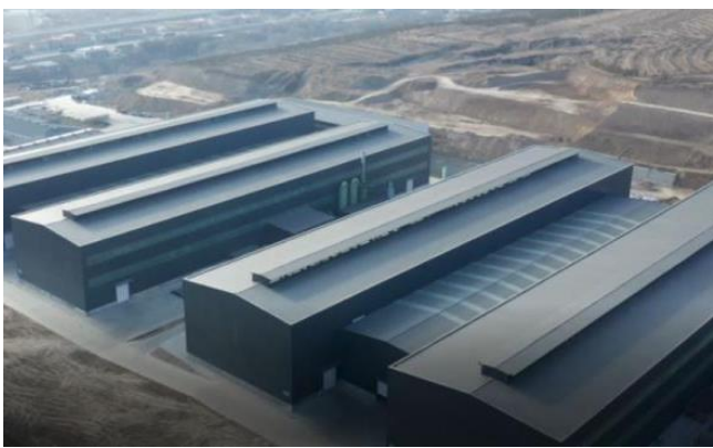
图 19: 璞泰来内蒙兴丰新能源工厂
